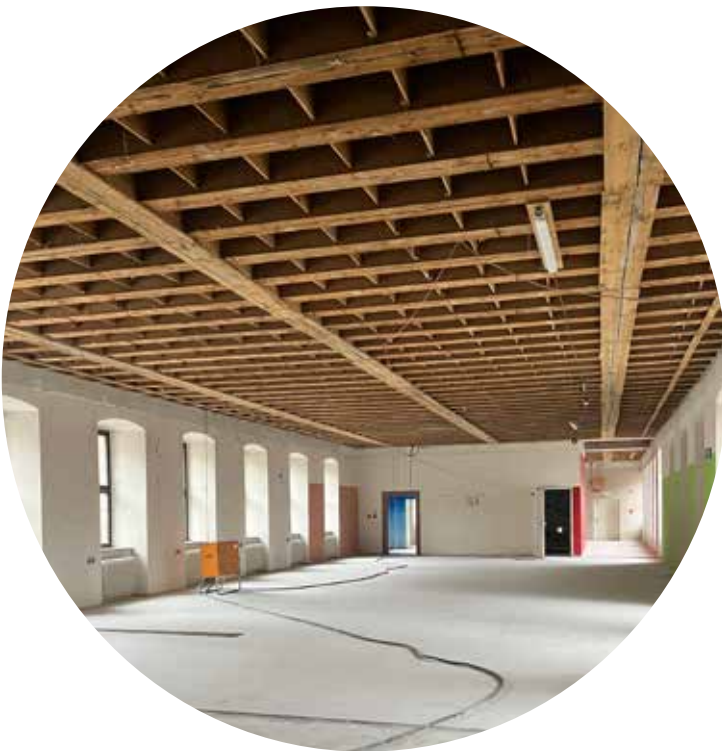
Baustellensituation im 1. OG des Kellereischlosses (Nov. 25)
