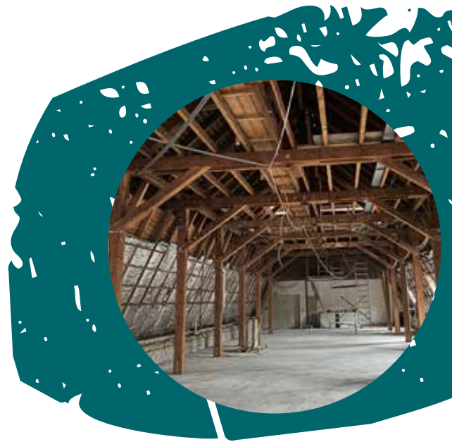
Baustellensituation im 2. OG Kellereischlosses (Nov. 25)
