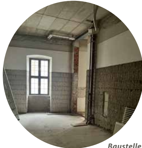
Baustellensituation im Sanitärbereich des Kellereischlosses (Nov. 25)
